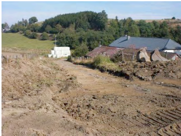
Excavation du chemin d'accès.
