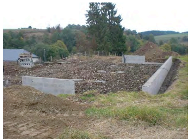
Construction du muret de soutènement.
