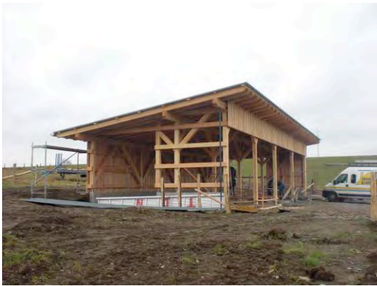
Fermeture de l'abri par un bardage vertical.
