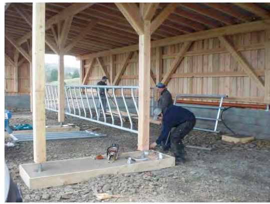
Installation des équipements galvanisés.
