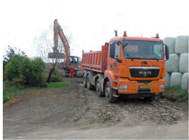
Empierrement du chemin d'accès.
