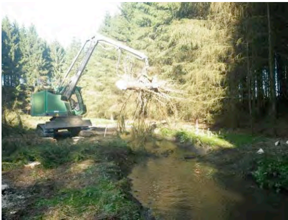
Placement des cimes dans le cours d'eau.
