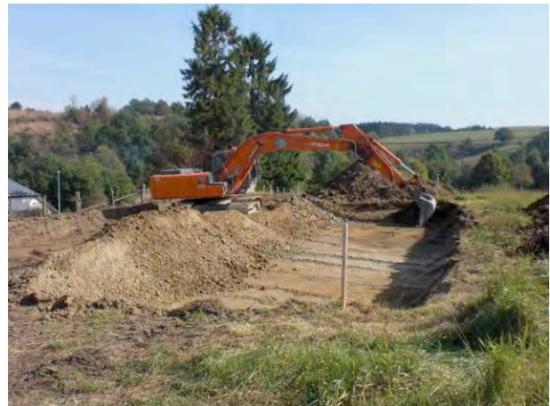
Travaux de terrassement.
