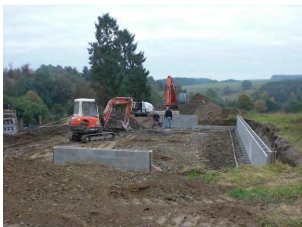
Construction du muret de soutènement.
