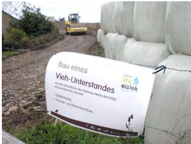
Installation de panneaux de chantier provisoires.
