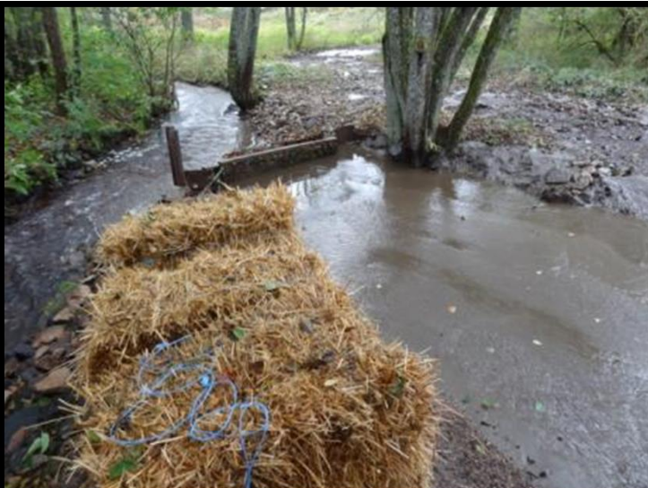
Creating a new straw filters Coût : 305 euros HT
