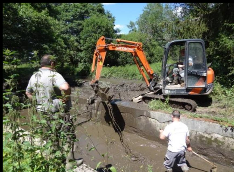
Mechanical cleaning Coût : 1 600 euros HT
