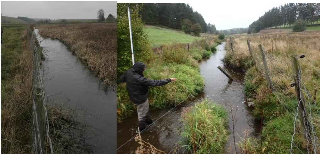
Figure 18 – Photos du tronçon rectiligne à restaurer, avec un profil « rectangulaire ».
